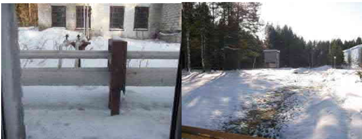
Рис.2.9. Состояние теплосетей от котельной РДС «Сельчка»
